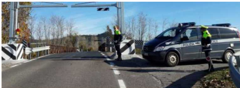
I portali installati lungo la provinciale Montorsina per impedire l'accesso ai mezzi pesanti
