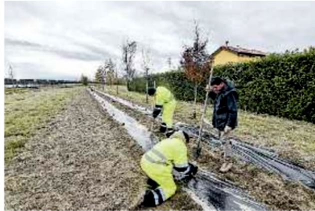
AUTOSTRADA VERDE Ieri nel corso di una cerimonia sono state collocate le prime piante lungo il passante a Mirano
