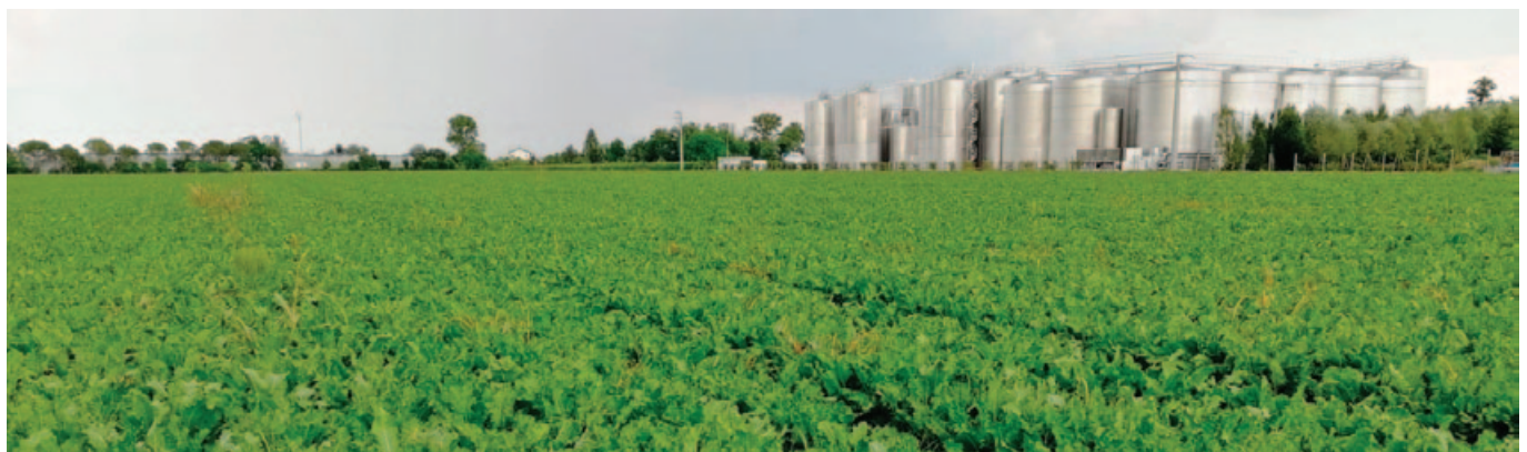
Biogas San Vittorio
