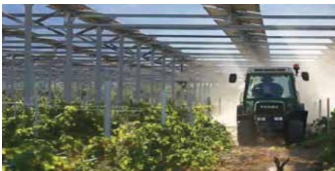
Impianto agrovoltaico realizzato in ambito vitivinicolo (© SUN'AGRI) Fonte: Report di Solar Power Europe
