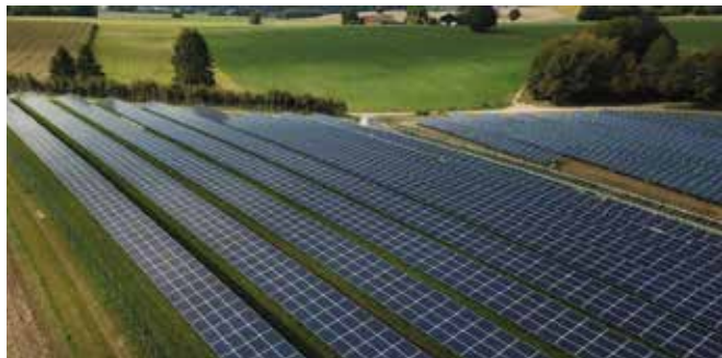
Campo fotovoltaico con strutture fisse
