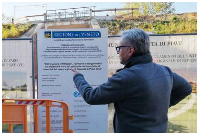
Visita a un cantiere.
